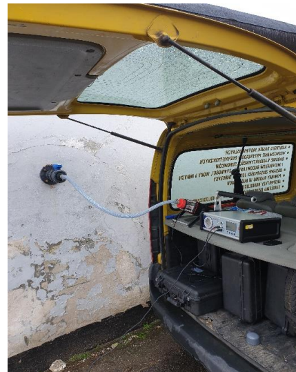
Pomiar zawartości pochodnych rozpadu radonu w powietrzu pobranym z obiektów nr 2 i 3.
