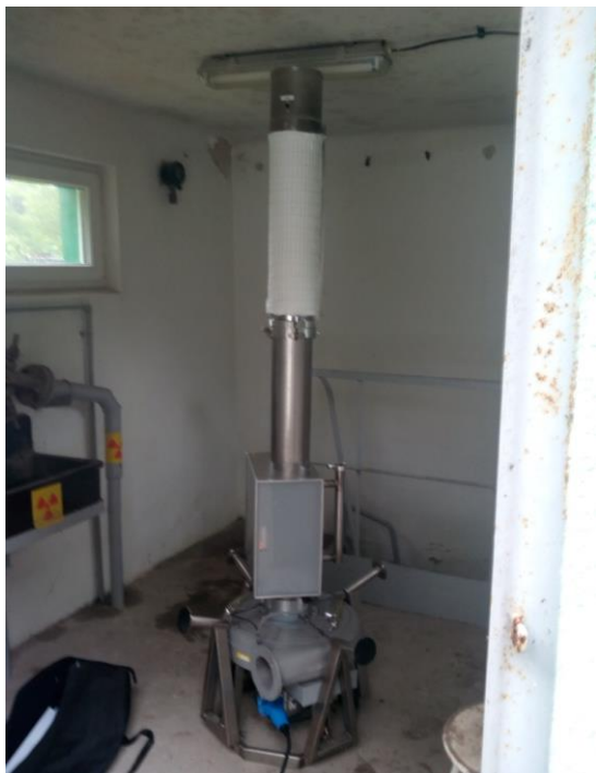
Pobór próbki aerozoli powietrza w obiekcie 51
