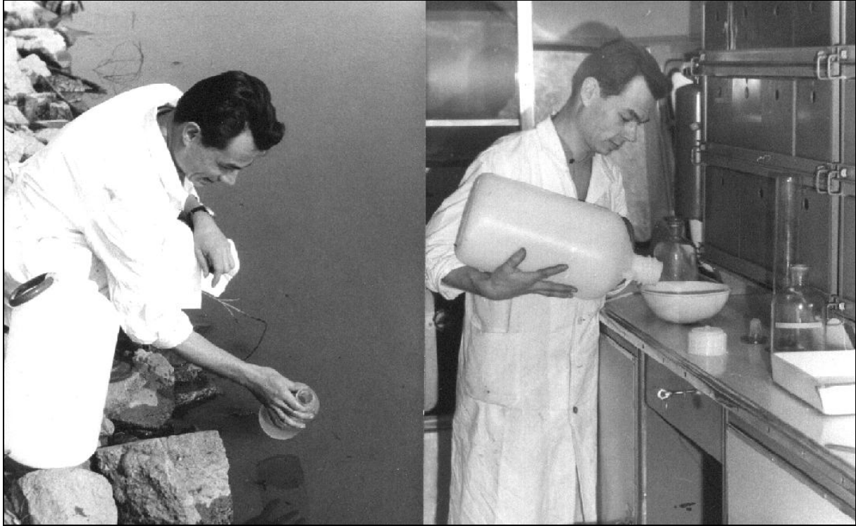
Fig. 19. Pobór próbki wody z rzeki i przygotowanie jej do pomiaru radioaktywności.
