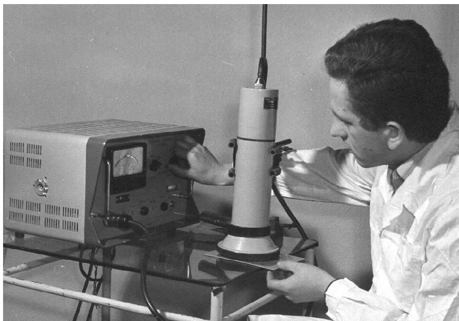
Fig. 6. Pomiar promieniowania alfa radiometrem sowieckim typu Rus-5a.
